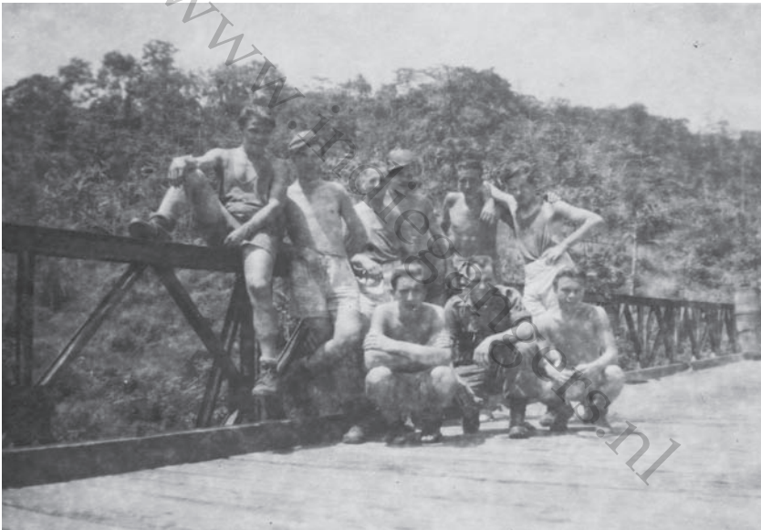
4-6 R.I. op de nieuw aangelegde baileybrug.
