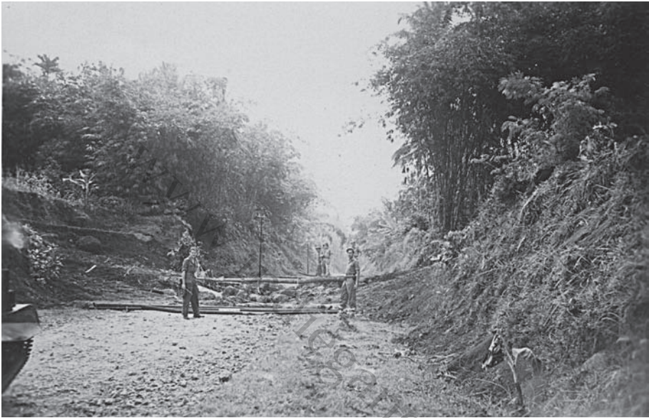
Holle weg met wegvsperring voor hinderlaag.
