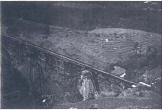
een schitterend gezicht op de spoorbrug
