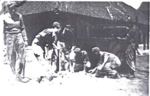
stoere werklui bezig met het herstellen van de weg ik sta met de grote hamer in de handen
