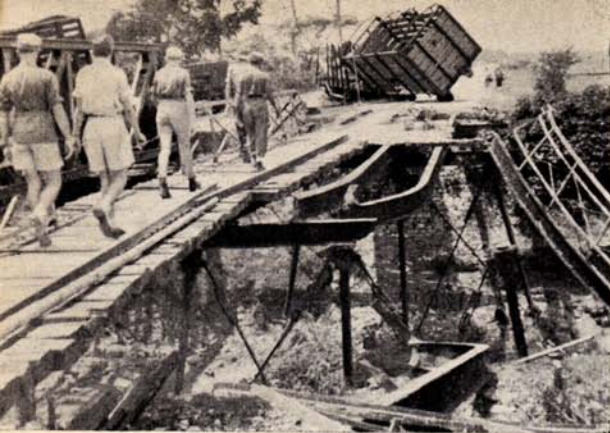
Door T.N.I. opgeblazen..... en herstelde brug (Ngawen)
